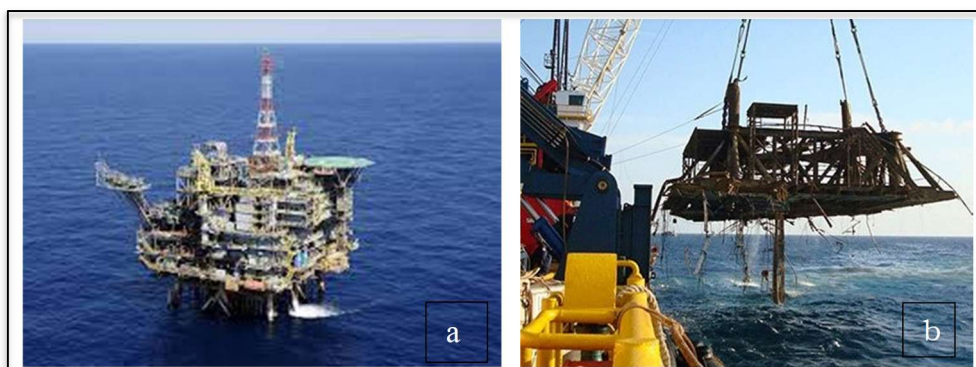
Figura 3: a) Plataforma tipo fixa em operação-topside, (b) Plataforma em descomissionamento.
